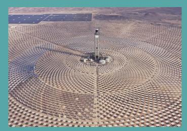
Cerro Dominador, Atacama, es la primera planta de Concentración Solar latinoamericana, proyecto que utiliza tecnologías de concentración solar de torre y fotovoltaicas. El proyecto ya se sincronizó con el sistema eléctrico chileno en forma exitosa
